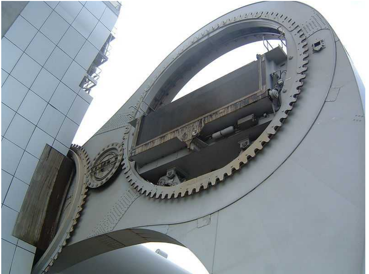
Abbildung 11: Zahnradgetriebe, um die Troge waagrecht zu halten
